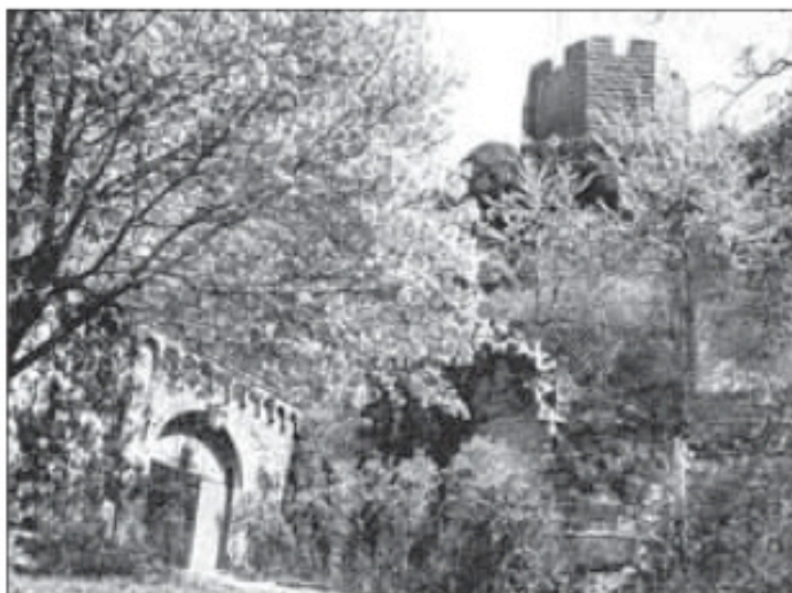
Eine Burg im Wandel: Der Eingangsbereich der Burg in den 50er Jahren. Foto: Lörz
