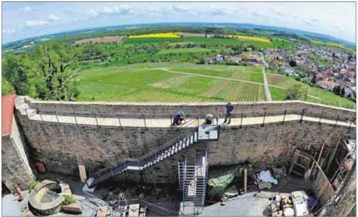
Die letzten Arbeiten an der südlichen Ringmauer - dann kann der Besucher den Blick in den Kraichgau genießen und der Zugang zum Obergeschoss des Palas wird dann auch möglich sein. Foto: Lörz
